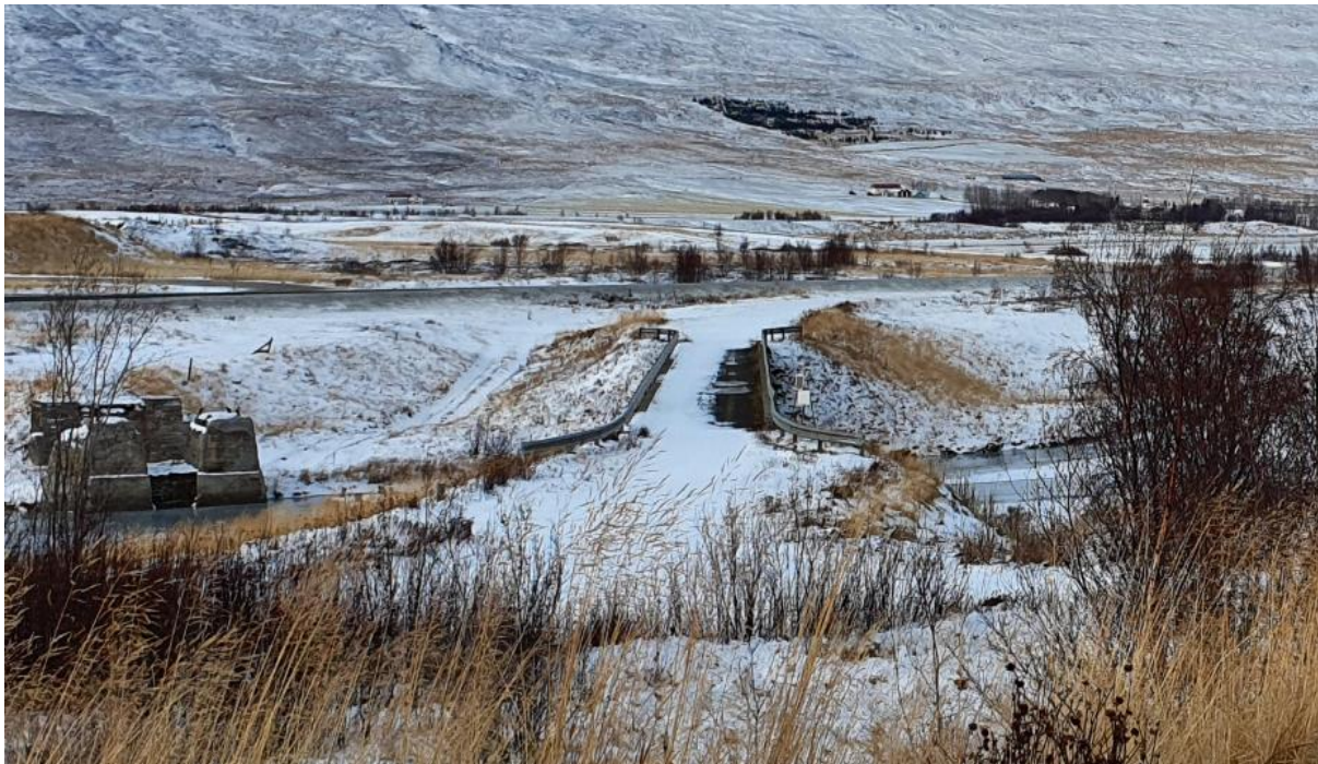
Mynd 2. Lagnaleið DA2 yfir Hörgá, gamla brúin notið sem lagnaleið fyrir strenginn.
